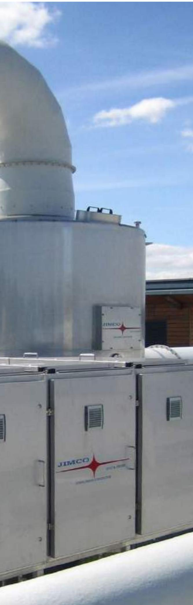
Los sistemas FLO-K se fabrican y suministran para diversas tareas. El sistema se puede instalar en un conducto de escape común de diversos procesos empleados en la producción de, por ejemplo, comidas precocinadas.
